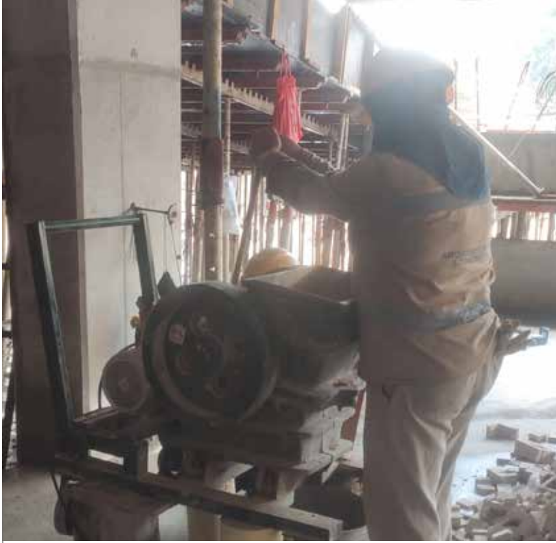
Fotografía 19. Proceso al interior de la obra Acuarela del Parque - ubicada Municipio de Medellín (17/03/2022)
