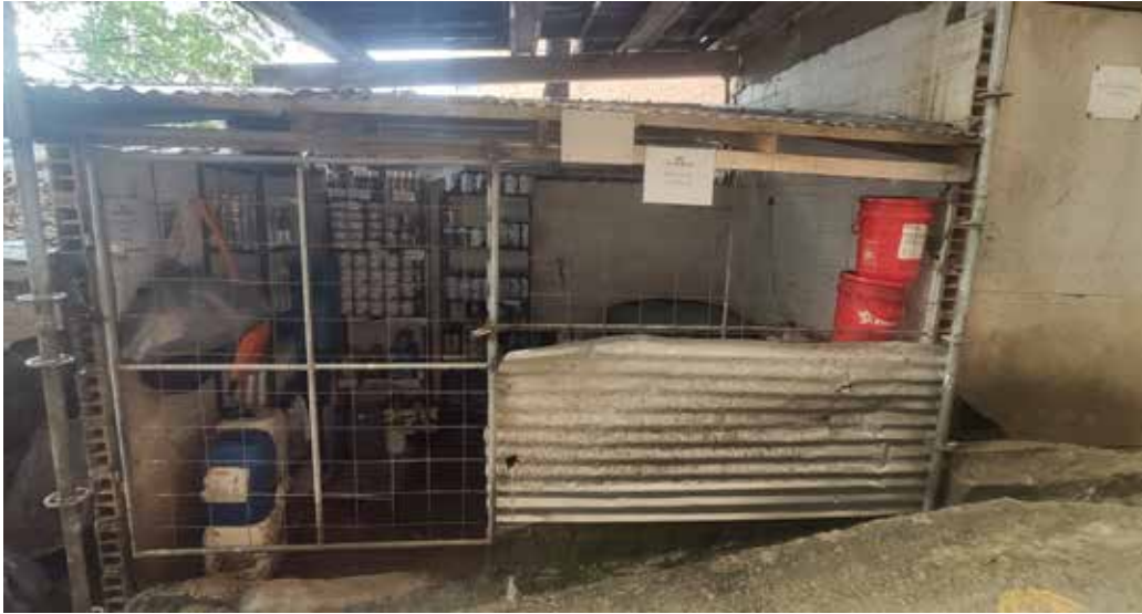
Fotografía 9. Buenas Prácticas obra Dublin
