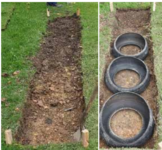
Fotografía 14. Proceso realizado en la estructura de pavimento
