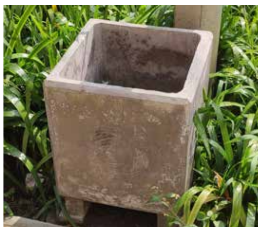
Fotografía 23. Elementos para exteriores con agregados reciclados provenientes del sobrante de concreto Acuarela del Parque - Medellín (17/03/2022).
