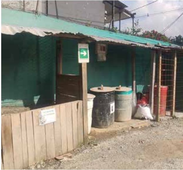
Fotografía 3. Área de almacenamiento temporal de distintos RCD en Suramérica Park – La Estrella (11/04/2022)
