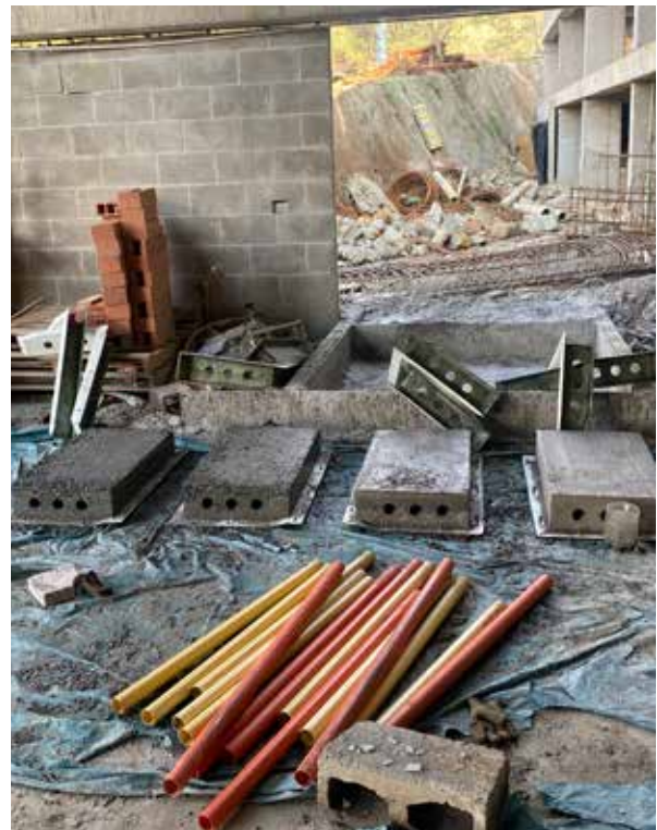
Fotografía 17. cordones construidos en obra con agregados fino del PET utilizados en obra
