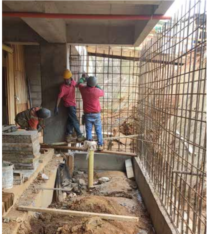
Fotografía 7. Buenas prácticas obra mi mundo Bello.
